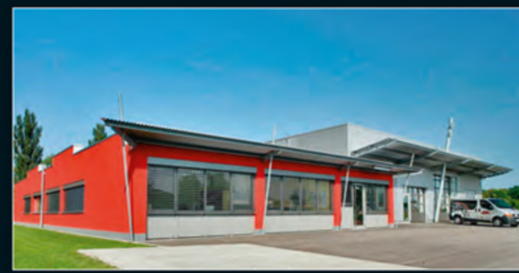
Das neue Firmengebäude unter der badischen Sonne teilt sich ABM mit Spiegler Bremstechnik
